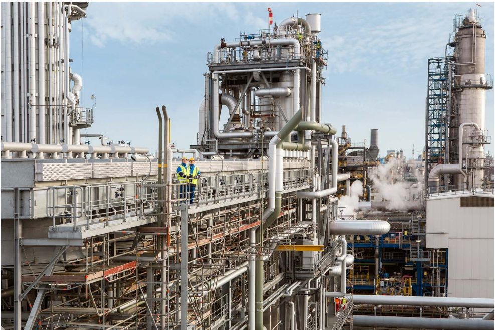
Bild 1.1 Verfahrenstechnische Anlage zur Herstellung von TDI, eines Vorprodukts von Polyurethan (BASF SE)
