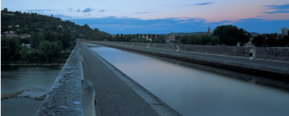
Le Pont Canal d'Agen, which takes the Canal des Deux Mers across the Garonne
