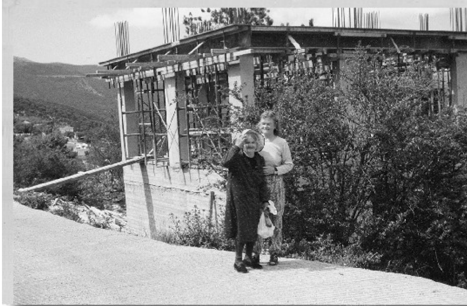
Katherini besichtigt die Baustelle.
