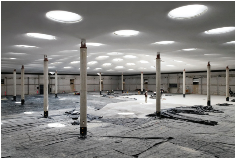
Bild 2-2 Der Ausstellungsraum in der Bauphase mit Tageslicht ausgeleuchtet © Kirsten Bucher
