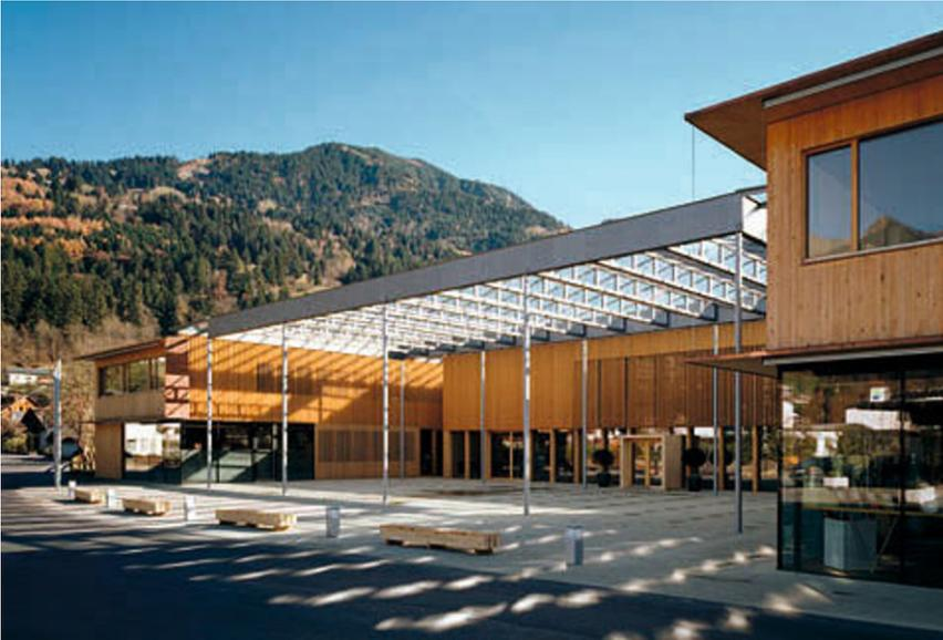
**Bild 2-2** Gemeindezentrum Ludesch, Vorarlberg. Das in Holzbauweise nach dem Passivhausstandard 2005 errichtete Gebäude vereint hohe Energieeffizienz, natürliche Baustoffe und nachgewiesenermaßen exzellente Werte für die Qualität der Innenraumluft und erbringt den Beweis, dass energiesparende Bauweisen und Wohngesundheit kein Widerspruch sind.
