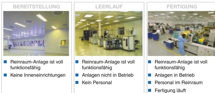
**Abb. 1.6** Betriebszustände zur Festlegung und Überprüfung der Luftqualität
