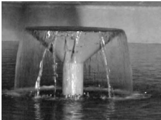
Innenraum des Trinkwasser-Hochbehälters in Peiting
