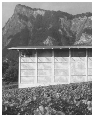
b) Digital gestaltetes und gefertigtes Aus- fachungsmauerwerk des Weingutes Gantenbein, Schweiz (Foto aus [2.23])
