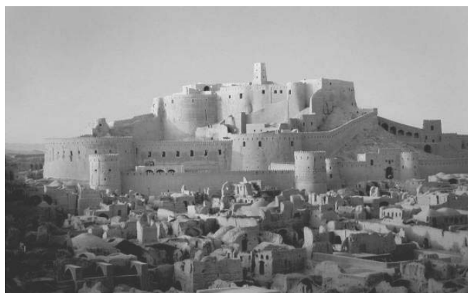
Bild 2-2 Die Zitadelle von Bam vor der Zerstörung 2003 –ca. 2500 Jahre Tradition im Mauerwerksbau mit ungebrannten Lehmsteinen (Foto: Recovery Project of Bam's Cultural Heritage)
