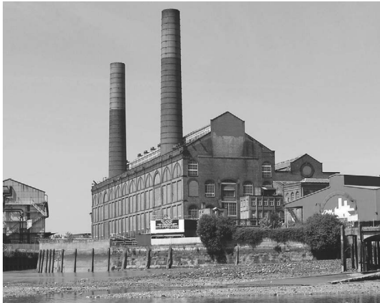
a) Gemauerte Schornsteine im Kraftwerk Lots Road, erbaut 1902–05, London, UK (Foto: Adrian Pingstone, Bristol, UK)
