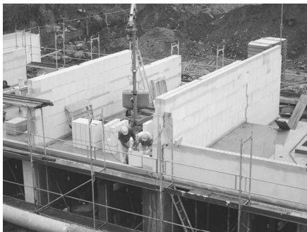
a) Neubau einer Reihenhauses-Wohnanlage in Dresden („Lucas-Areal“) mit Kalksandsteinmauerwerk
