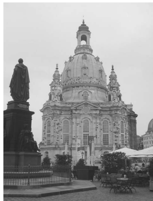
b) Ingenieurmauerwerk - Wiederaufbau der Frauenkirche Dresden (Foto: T. Albrecht, Dresden)
