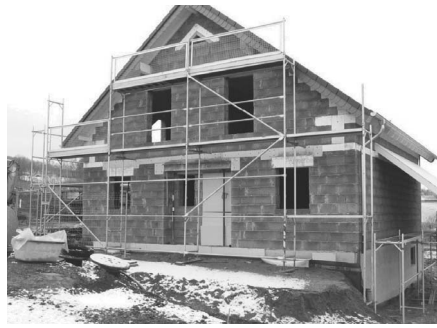
b) Neubau eines Einfamilienhauses in der Nähe von Bonn mit Leichtbetonmauerwerk
