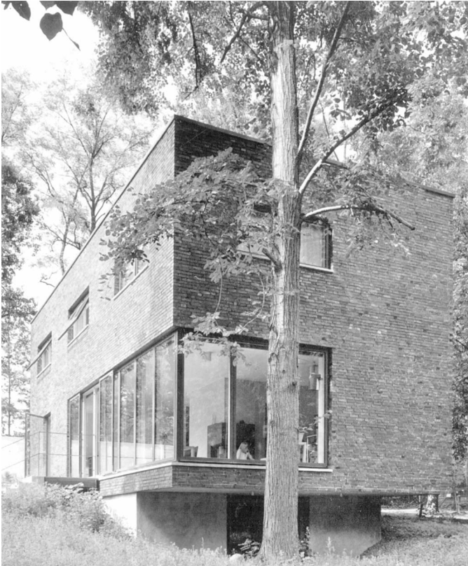
Bild 1-2 Moderner Mauerwerksbau der heutigen Zeit (Haus Reichert, Wilhelmshorst/Potsdam) [1.3]
