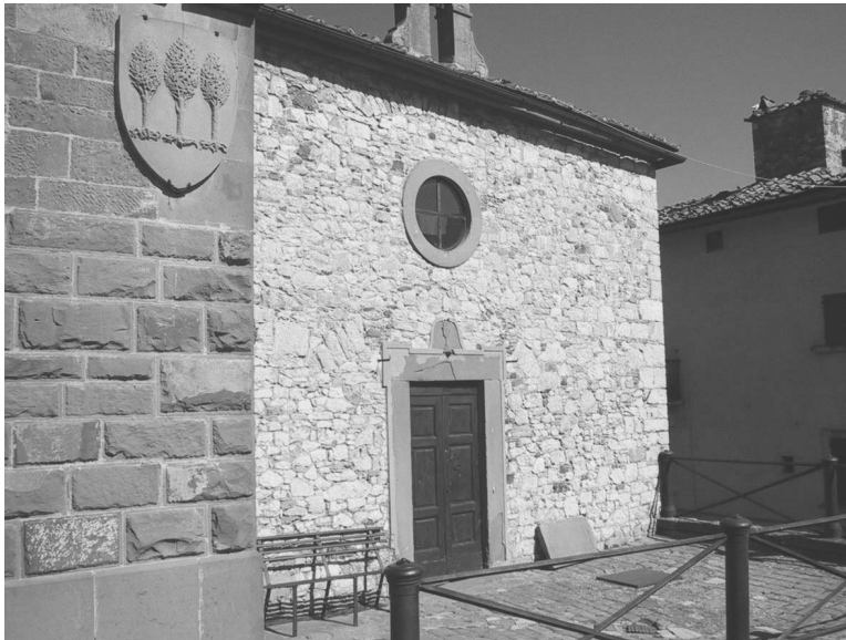
Bild 1-1 Natursteinmauerwerk verschiedener Epochen an der Prepositura di San Nicolò in Rada, Italien
