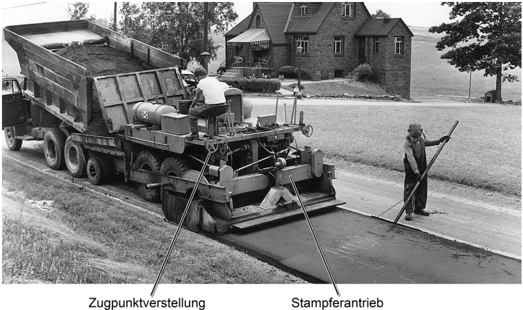
Abb. 1.16 Erster Radfertiger von Blaw-Know auf Basis des von APSCO 1953 entwickeltem BF-90: Volvo Road Machinery Inc.; Shippensburg, PA, USA
