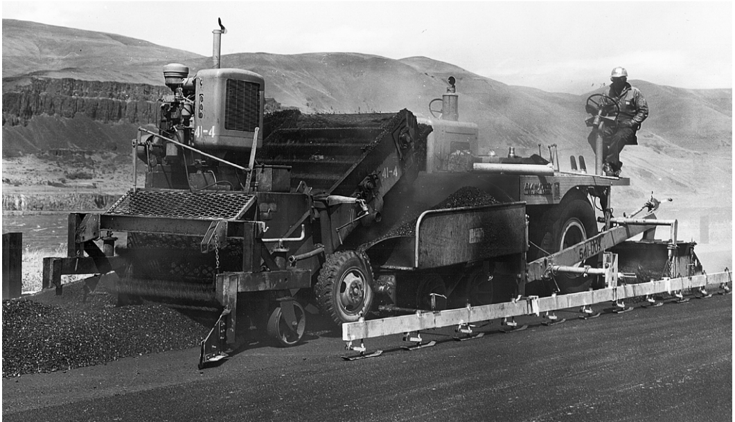
Abb. 1.13 Früher Straßenfertiger in den USA mit einer Windrow-Pick-Up-Maschine als Beschicker: Volvo Road Machinery Inc.; Shippensburg, PA, USA
