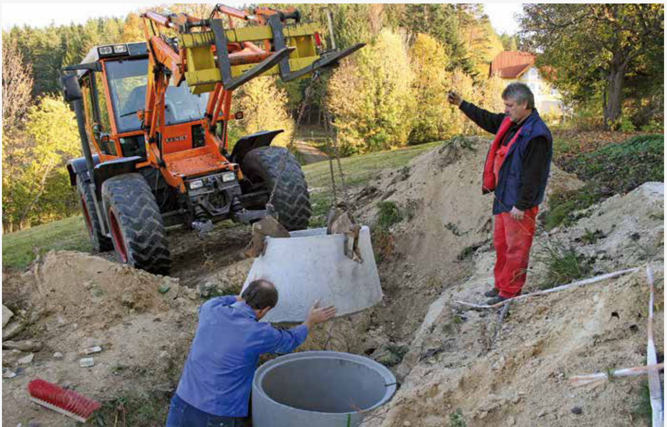
Abb. 9: Verfüllen der Baustelle um den neuen Einstiegsschacht des Erdstalles Kandelhofer (Steiermark).
