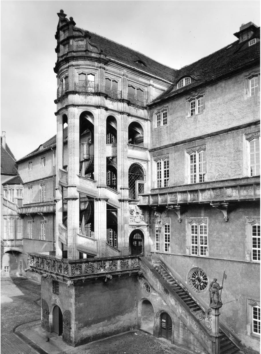
Großer Wendelstein vom Johann-Friedrich-Bau des Schlosses Hartenfels in Torgau (vor der Restaurierung), 1533–36 von Konrad Krebs geschaffen, gilt als eine Hauptleistung der Frührenaissance in Deutschland
