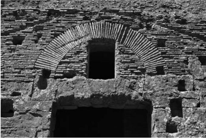
**Bild 2.8** Römischer Rundbogen aus Ziegelmauerwerk mit dicken keilförmigen Mörtelfugen und scheinrechter Bogen in mörtelloser Werksteinkonstruktion (römisches Theater, Ferento, Latium).
