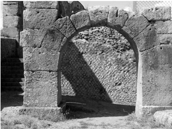
**Bild 2.1** Römischer Rundbogen aus mörtellos gefügtem Werkstein (römisches Theater Férento, Latium).
