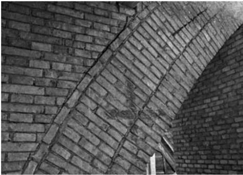
**Bild 2.9** Wölbung mit Backsteinen in mehreren konzentrischen Ringen und mit Bogen-Deckschicht (typische Konstruktion der Mitte des 19. Jhs.; Pfarrkirche St. Johann Baptist, München-Haidhausen).
