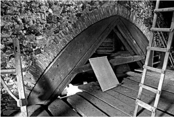
**Bild 2.11** Im Blockverband gemauerter Spitzbogen aus Backsteinen auf einem vor Ort belassenen Lehrgerüst des 19. Jhs. (Pfarrkirche Bergen/Chiemgau).
