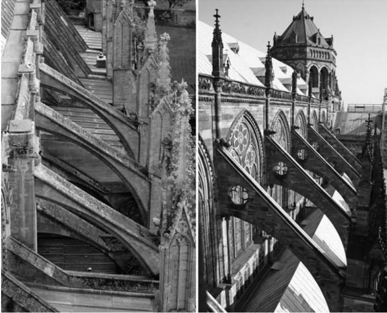
**Bild 2.4** Freistehende gemauerte gotische Strebebögen unterschiedlicher Geometrie (links: Kathedrale von Ely, England; rechts: Münster von Straßburg, Elsass).
