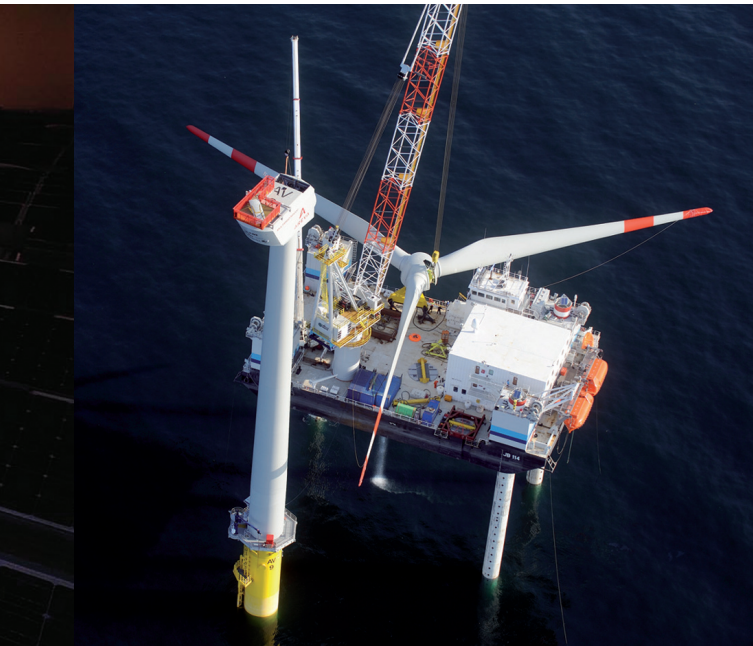
Montage einer Windenergieanlage im Offshore-Windenergiepark Alpha Ventus, der 2009 in der Nordsee in Betrieb ging (Foto: alpha ventus).
