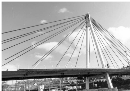
Bild 5: Storchenbrücke in Winterthur; Länge 124 m
