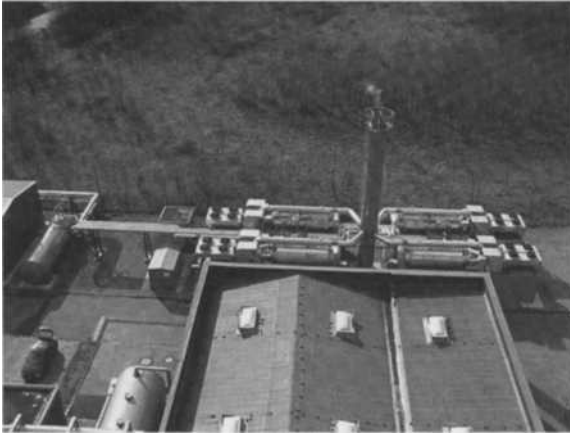
Abb. 1.3 Blockheizkraftwerk in Dortmund/Derne mit vier Modulen der G.A.S. Energietechnologie GmbH (Auftragswert: ca. 3 Mio. €)
