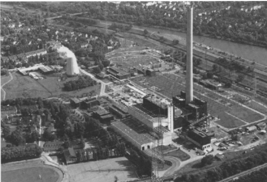
Abb. 1.4 Aufnahme des Müllheizkraftwerkes mit Rauchgasreinigung und Abwasseraufbereitung der RWE Power AG in Essen-Karnap. Die Anlage hat eine Kapazität von ca. 750.000 t/a. Die Gesamtinvestition betrug ca. 1 Milliarde DM.
