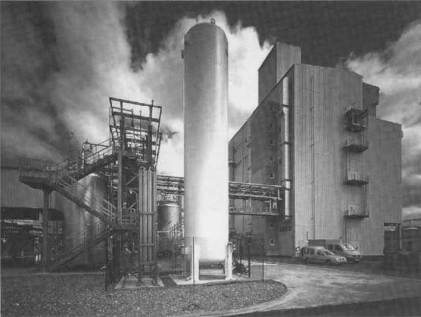
Abb. 1.2 Strobilurin-Anlage der BASF Schwarzheide GmbH mit einem Auftragswert von 14,9 Mio. €
