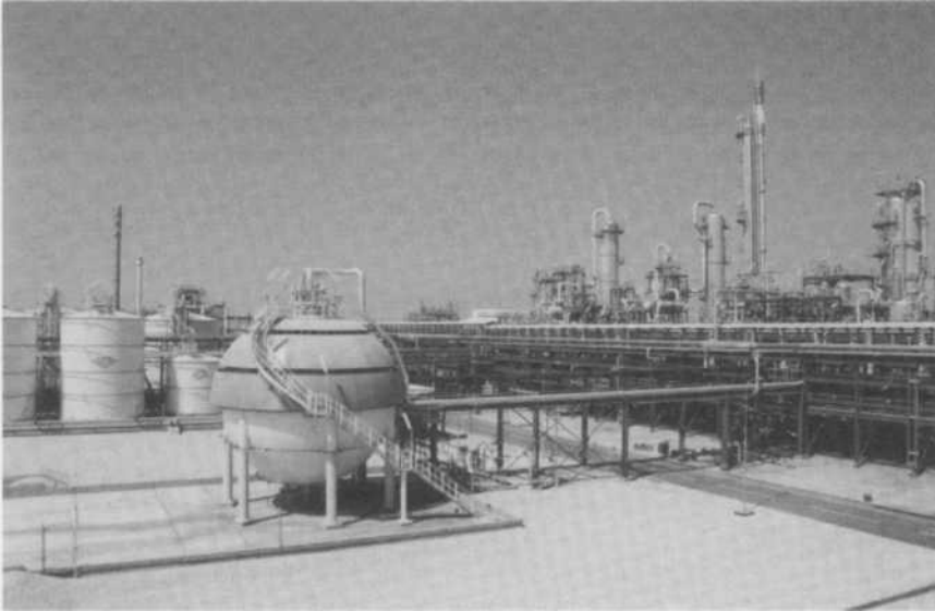
Abb. 1.5 Aufnahme des von der Fa. UHDE GmbH, Dortmund errichteten Chemiekomplexes in Katar. Der Chemiekomplex besteht aus drei Hauptanlagen zur Produktion von 260.000 t/a Chlor, 290.000 t/a Natronlauge, 175.000 t/a Ethylendichlorid und 230.000 t/a Vinylchlorid. Der Auftragswert betrug ca. 450 Mio. US- \text{\$} .
