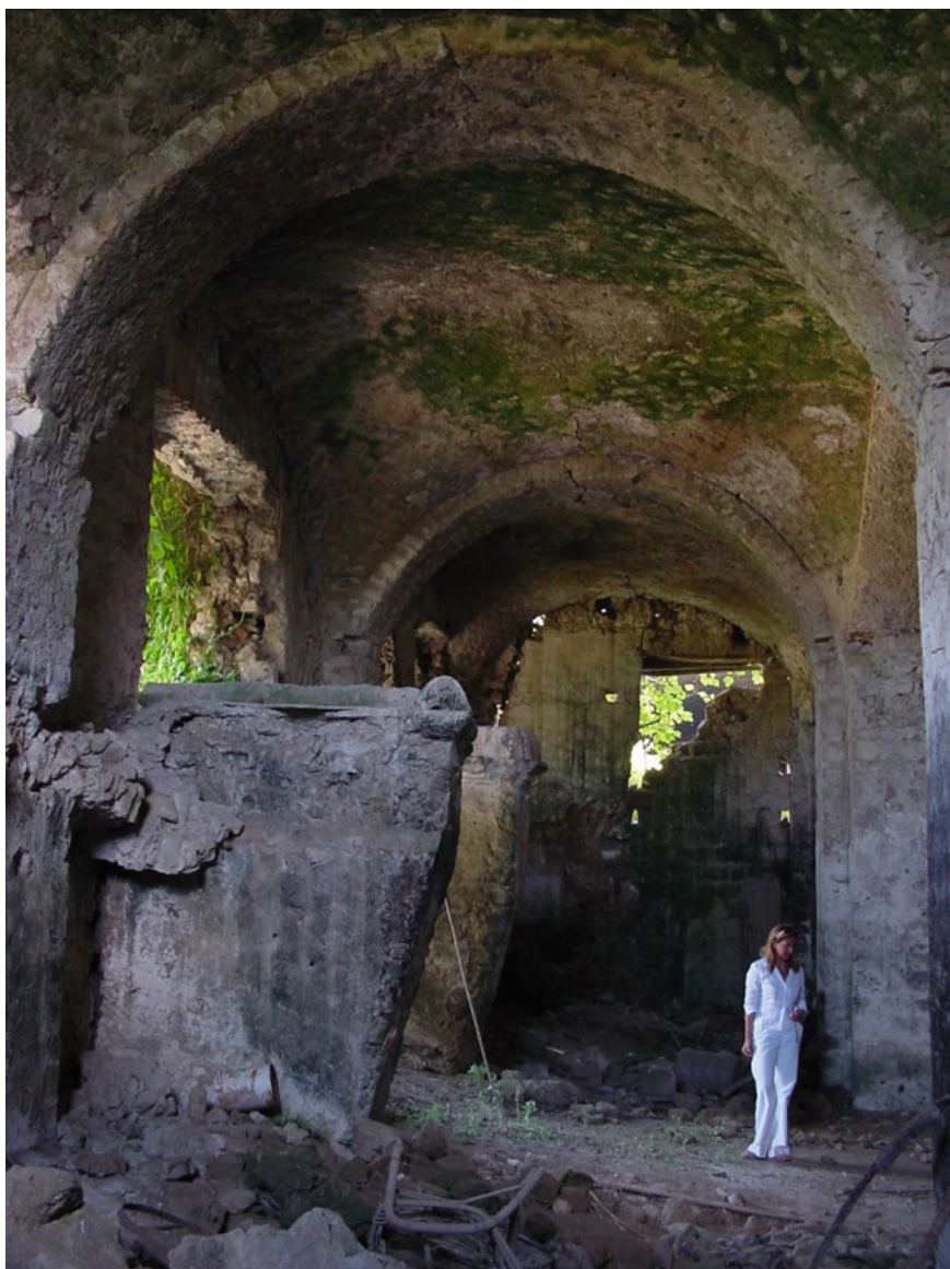
Pozzuoli (NA), Frà Vecchia farmhouse (XVIII sec.). Internal view of the cellaio
