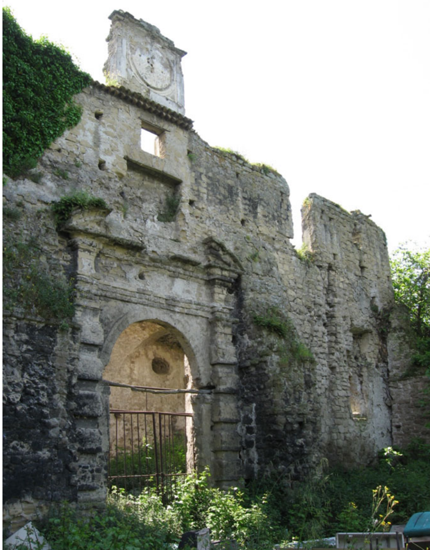
Pozzuoli (NA), Frà Vecchia farmhouse (XVIII sec.). Main facade of the manor house
