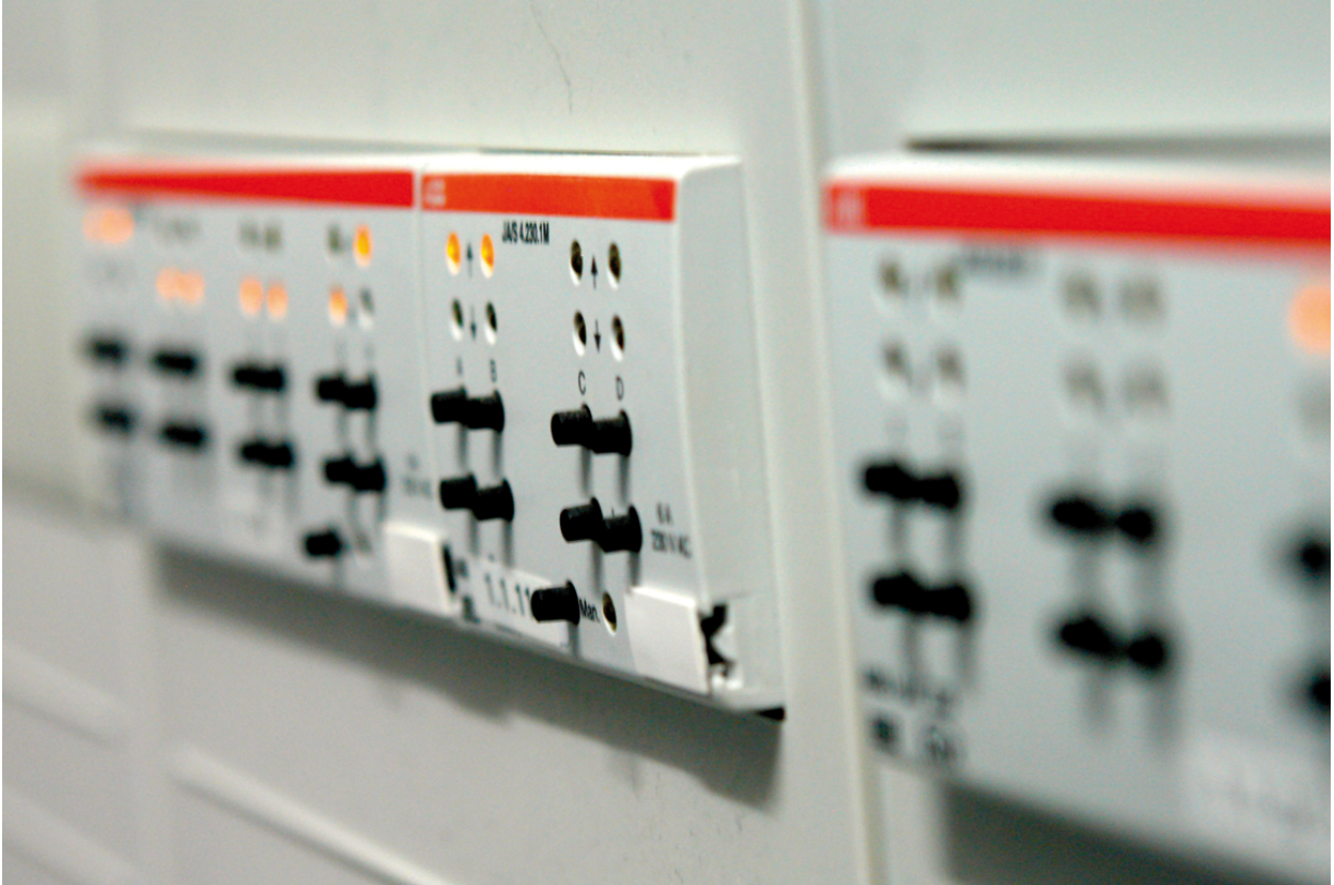
Abbildung 1.1: Klassische Businstallation mit Aktorik im Schaltschrank
