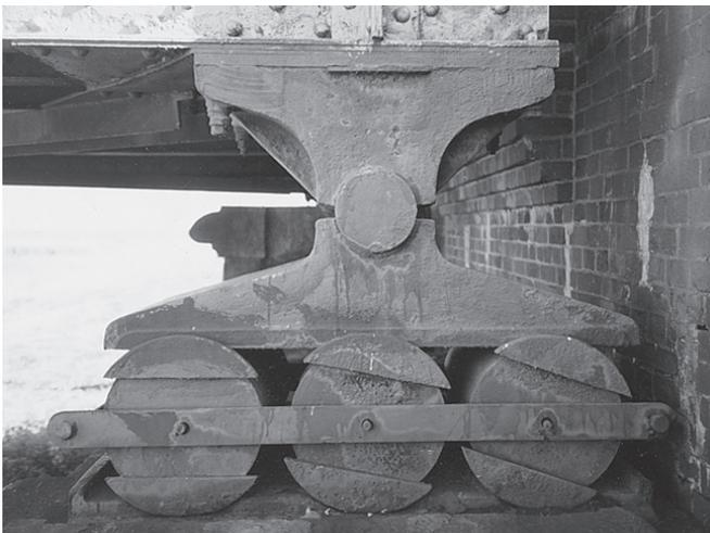
**Bild 1.10** Lager der ca. 100 Jahre alten Eisenbahnbrücke über die Eider bei Friedrichstadt: 3-Rollenlager. Verstoß gegen die Lagerungsgrundsätze 1 und 6
