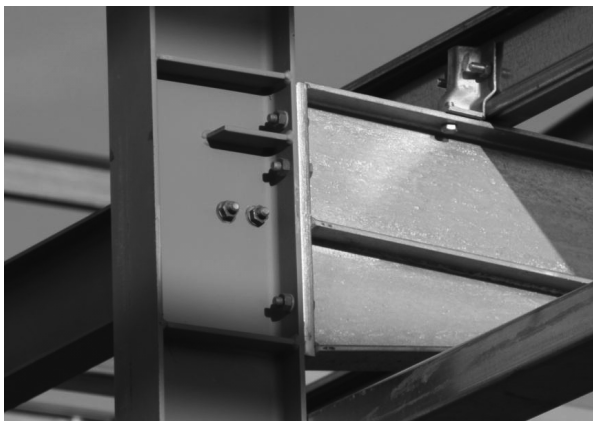
Bild 1.11 Geschraubte Rahmenecke
