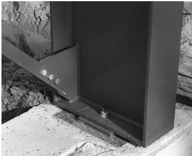
Bild 1.5 Gelenkiger Stützenfuß
