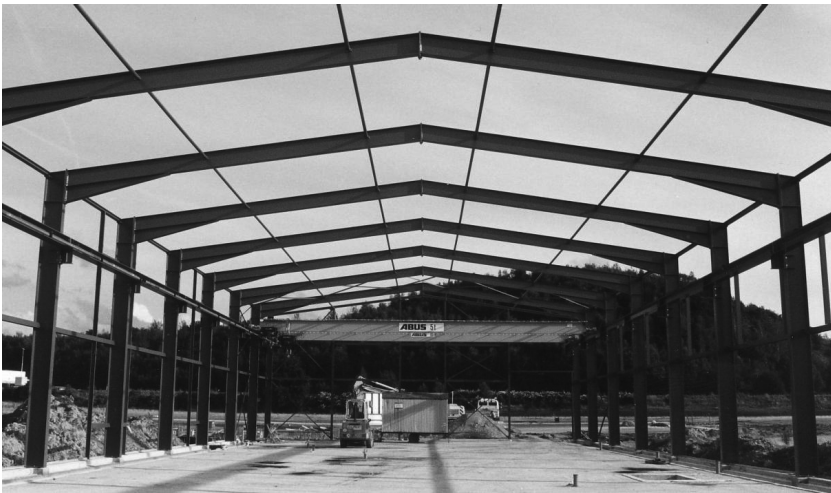
Bild 1.1 Zweigelenrahmen einer Fertigungshalle aus Walzprofilen
