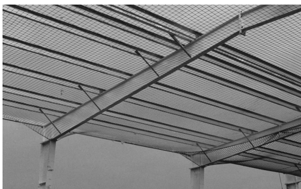
Bild 1.7 Dachpfetten, Schrägstreben und Rahmenriegel
