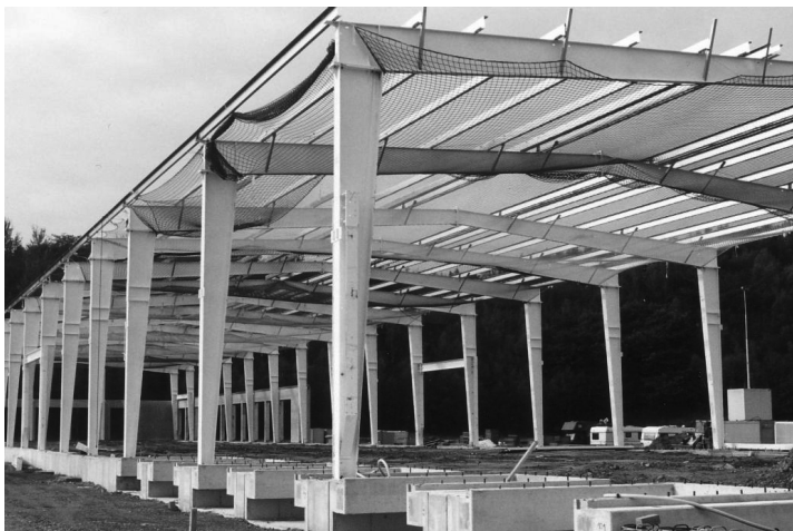
Bild 1.6 Geschweißte Zweigelenkrahmen einer Lagerhalle
