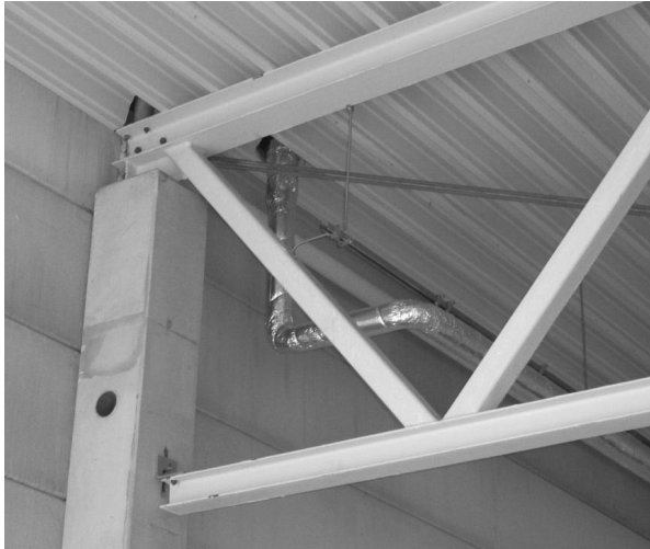
Bild 1.15 Auflagerdetail eines Fachwerkbinders
