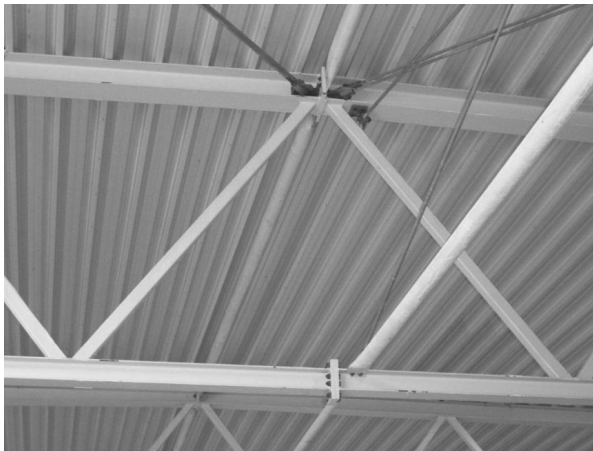
Bild 1.16 Detail Fachwerkbinder mit Stahltrapezblechen
