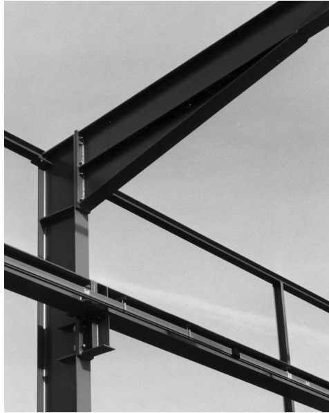
Bild 1.4 Rahmenecke mit Voute und Kranbahnträger
