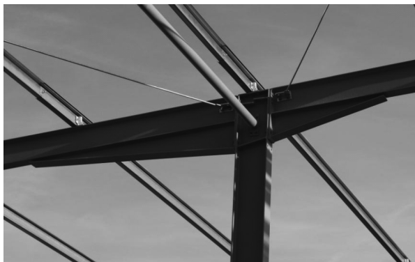
Bild 1.12 Mittelstütze mit Rahmenecken
