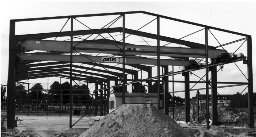
Bild 1.2 Giebelwandkonstruktion
