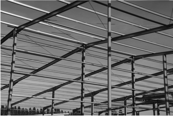
Bild 1.9 Rahmenkonstruktion und Dachpfetten
