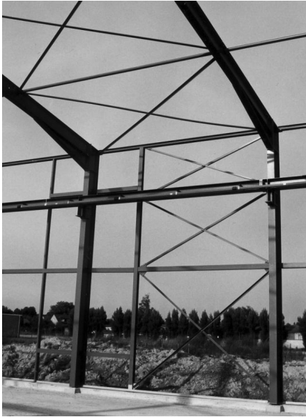
Bild 1.3 Wand- und Dachverband
