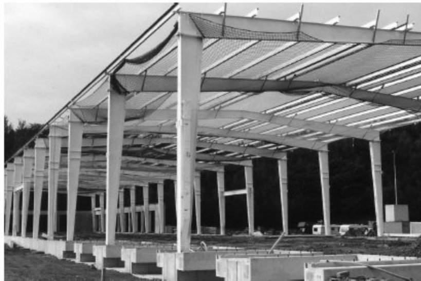
Bild 1.7 Dachpfetten, Schrägstreben und Rahmenriegel
