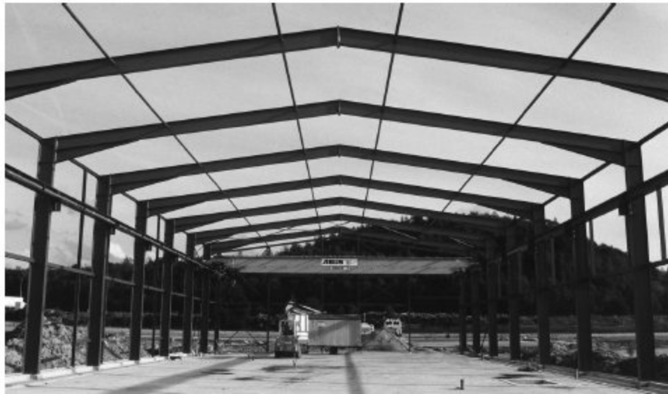
Bild 1.2 Giebelwandkonstruktion
