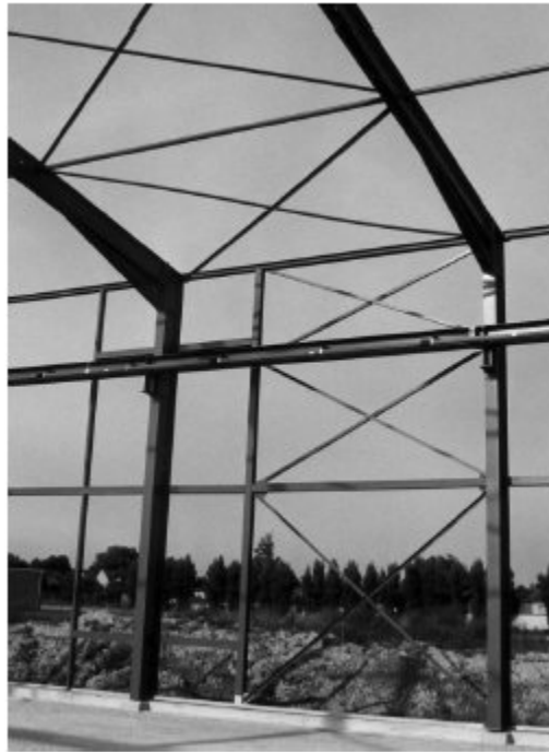
Bild 1.4 Rahmenecke mit Voute und Kranbahnträger
