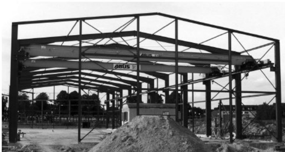
Bild 1.2 Giebelwandkonstruktion
