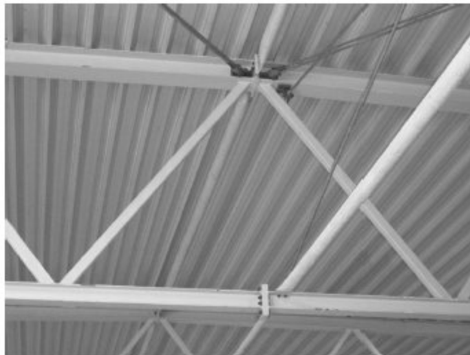
Bild 1.16 Detail Fachwerkbinder mit Stahltrapezblechen
