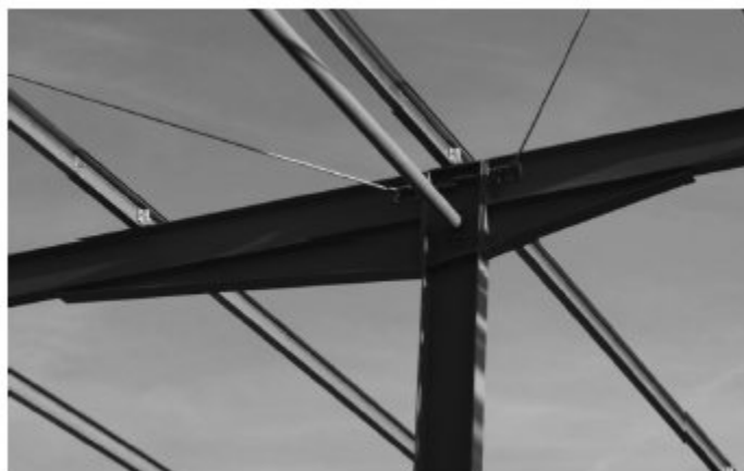
Bild 1.13 Giebelwandkonstruktion
