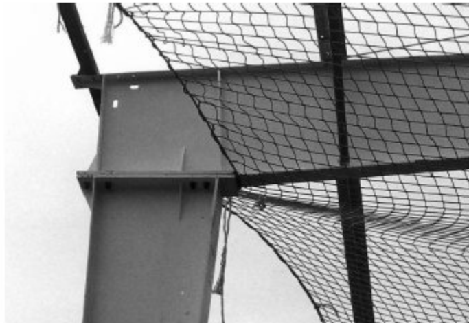
Bild 1.9 Rahmenkonstruktion und Dachpfetten
