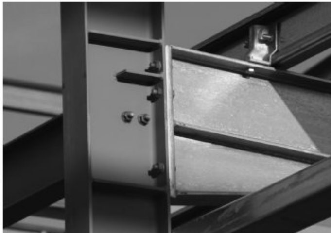
Bild 1.12 Mittelstütze mit Rahmenecken
