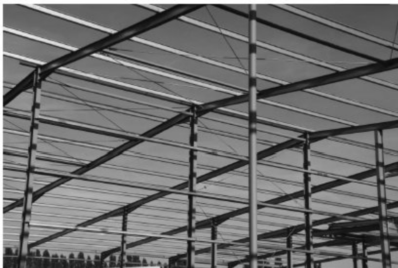
Bild 1.9 Rahmenkonstruktion und Dachpfetten
