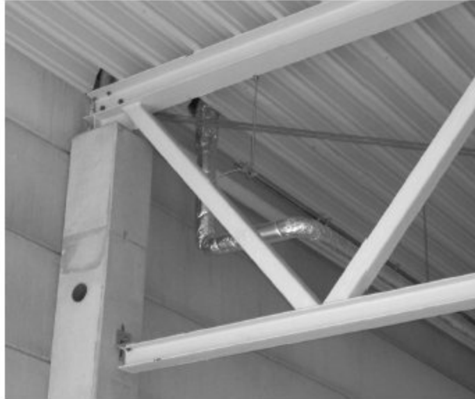
Bild 1.16 Detail Fachwerkbinder mit Stahltrapezblechen
