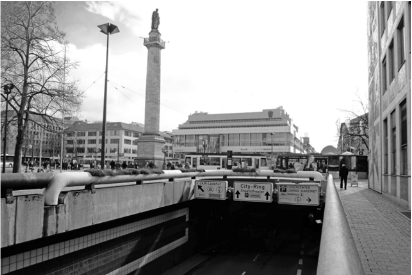
Citytunnel am Luisenplatz (Foto: Peter Noller)
