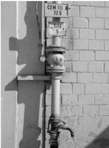
Bild 1.4: Entnahmevorrichtung für Proben am Silofüllstutzen
