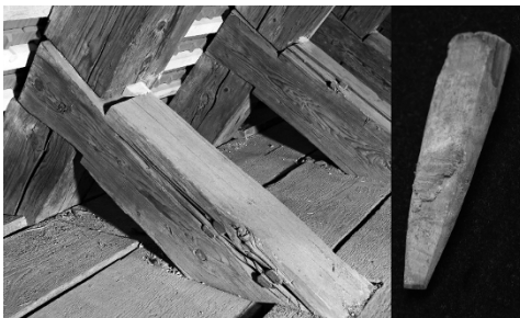
Bild 2.4 Floßkeile im Dachwerk der ev. St.-Ulrich-Kirche Augsburg (1710).
