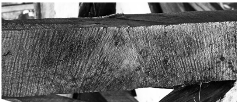
Bild 2.8 Spuren einer manuellen Längssägung an einem Viertelholz aus Eiche (Corvey, 17. Jh.).
