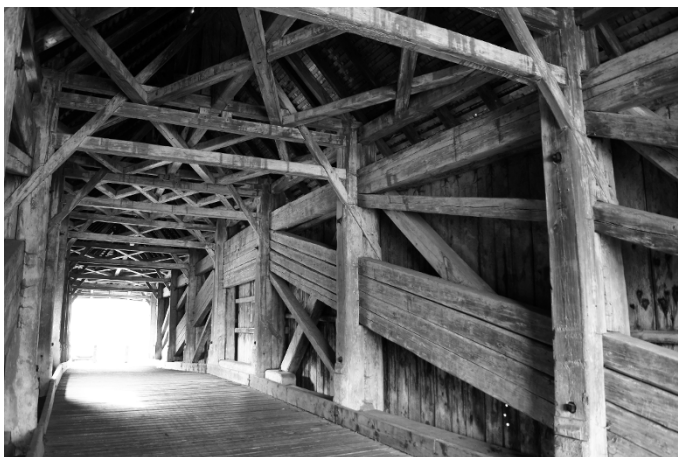
Bild 1.1 Holzbrücke des 18. Jahrhunderts (Argenbrücke Hiltensweiler).
