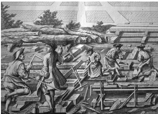
Bild 2.11 Abbinden eines Dachwerks [Schillinger 1745].
