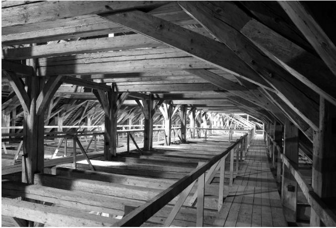
Bild 1.2 Historisches Dachwerk (ehem. Abteikirche Fürstenfeldbruck, frühes 18. Jh.).
