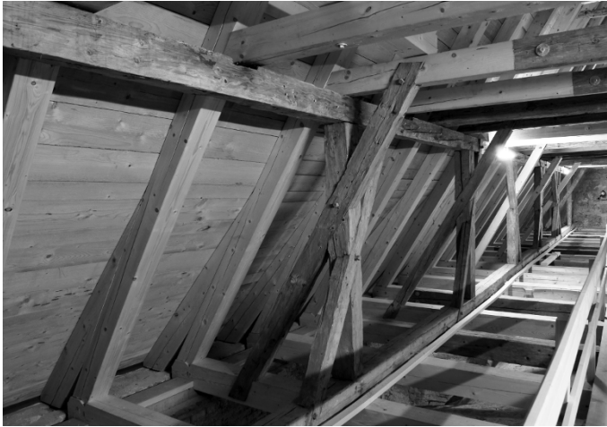
Bild 1.3 „Sanierung“ eines historischen Holztragwerks oder moderne Kopie mit wenigen alten Versatzstücken?
