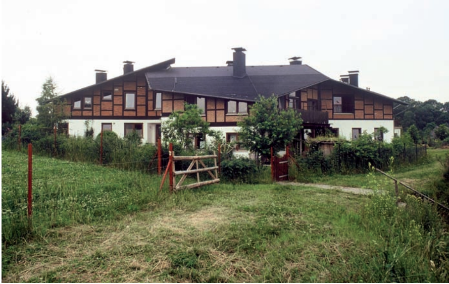
Abbildung 2: Dynamisch wirkende Schulbau-Fassade
