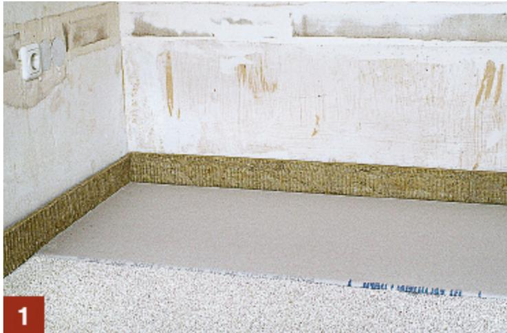
**Bevor die erste Lage Trockenestrichplatten aufgebracht wird, müssen Randdämmstreifen umlaufend an die Wand geklebt werden**
