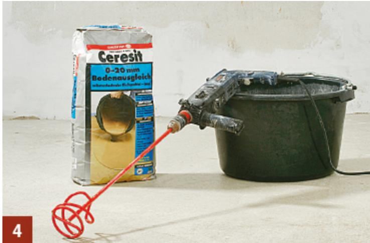
**Rühren Sie dazu die Ausgleichsmasse mit Bohrmaschine und Rührquirl an, lassen sie kurz ziehen und rühren dann nochmals auf**
