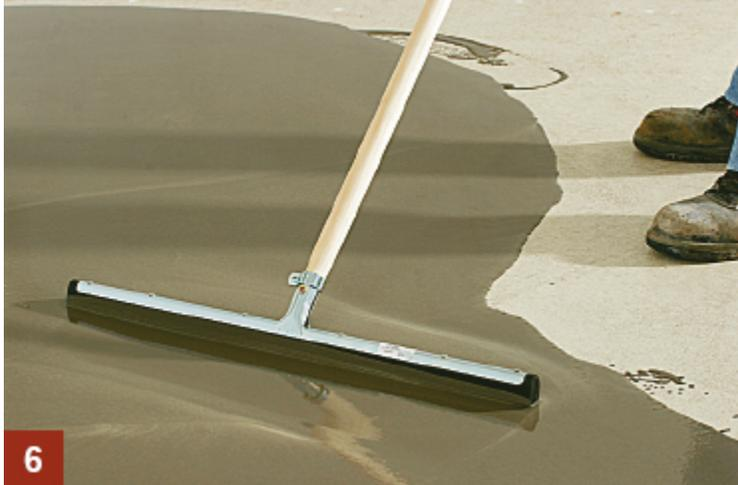
**Anschließend wird die Ausgleichsmasse sorgfältig verteilt. Die Abbindezeiten fallen bei den einzelnen Produkten unterschiedlich aus**
