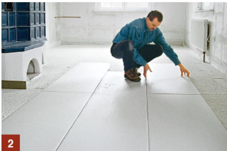
**Die erste Lage Estrichplatten dient dem Lastausgleich, in diesem Fall kommen 9,5 mm starke Gipskartonplatten zum Einsatz**
