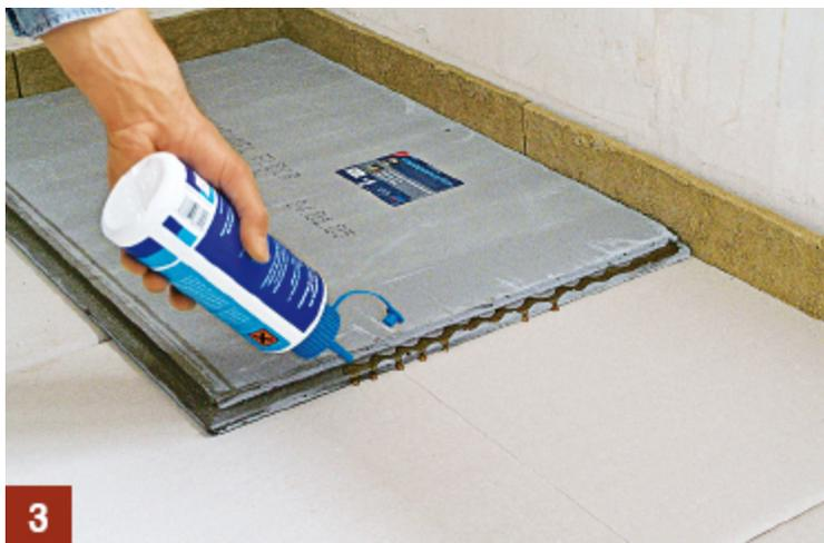
**Die zweite Lage besteht aus Zementbauplatten. Zunächst wird der PU-Falzkleber aufgetragen, dann wird die nächste Platte angefügt**
