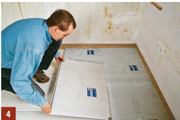
**Die Zementbauplatten müssen exakt in einer Flucht liegen und sollten beim Verlegen immer dicht zusammengestoßen werden**
