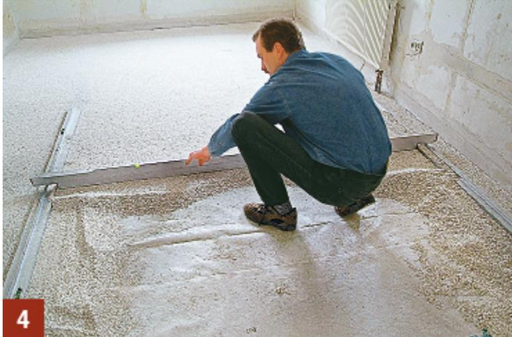
**Die zweite Lehre wird mittels eingebauter Wasserwaage sorgfältig ausgerichtet und über die Schüttung hinweg abgezogen**
