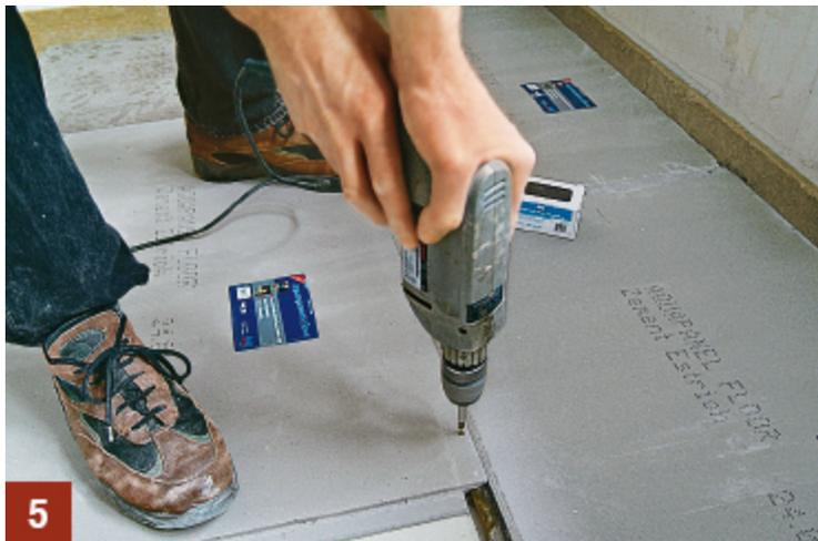
**Auch wenn die Zementbauplatten bereits am Falz verklebt sind, werden sie zur Sicherheit zusätzlich noch miteinander verschraubt**
