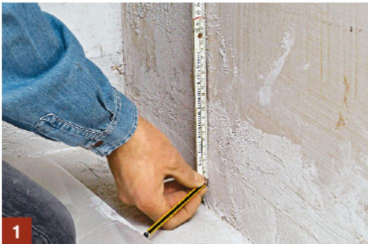
**Markieren Sie an den Wänden die nötige Höhe, um Unebenheiten ausgleichen zu können. Beim Ausmessen hilft ein Lasergerät**
