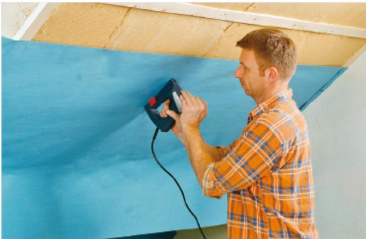
**Dampfbremse verlegen: Die Dampfbremsfolie verhindert Kondensfeuchte und Luftströmungen im Dachaufbau**
