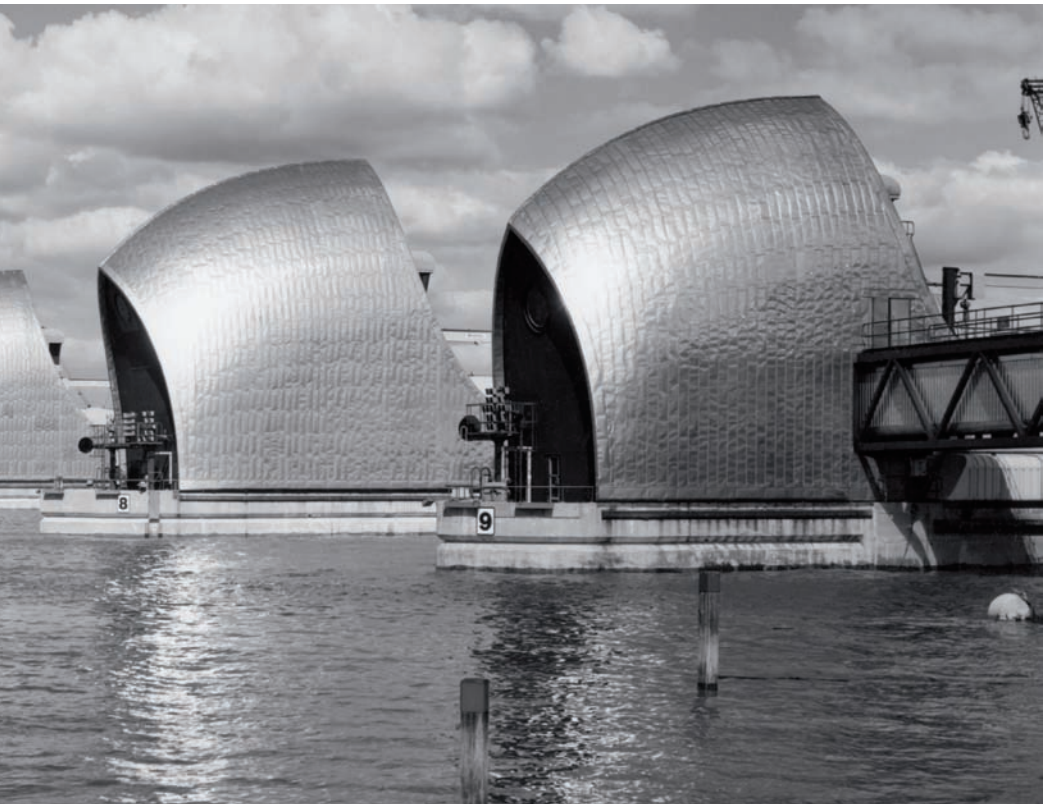
▲ Abb. 1 GLC Department of Public Health Engineering und Rendel Palmer & Tritton, Thames Barrier, 1982 fertiggestellt; Wollwich Reach bei London
