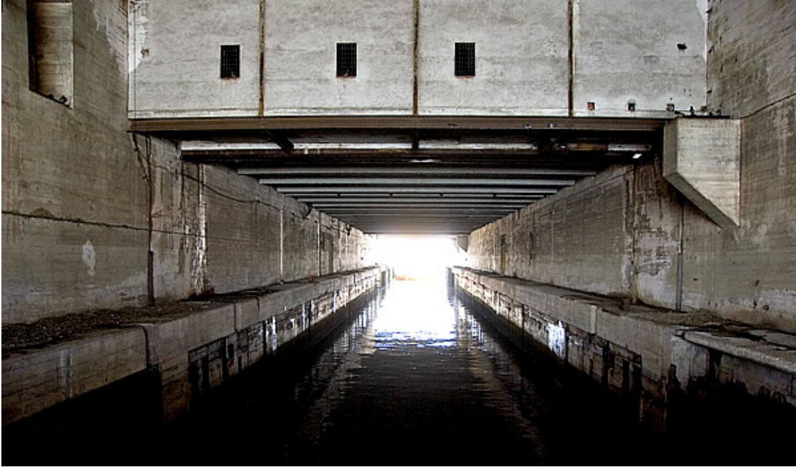
U-Boot-Schleuse La Pallice, Innenansicht. Foto: Pep.per de Ré, CC BY-SA 2.5.
