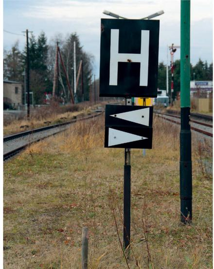
Die Zuordnungstafeln (weiße Dreiecke) waren einmal im »Geltungsbereich der DV 301« das Signal So 20. Sie haben sich mit den Richtungspfeilen im gesamten Netz der Deutschen Bahn verbreitet, zeigen sie doch bei unklaren Umständen an, für welches Gleis das Signal gilt.
