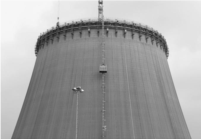
**Bild 8.** Kühlturm Neurath aus säurewiderstandsfähigem Beton
