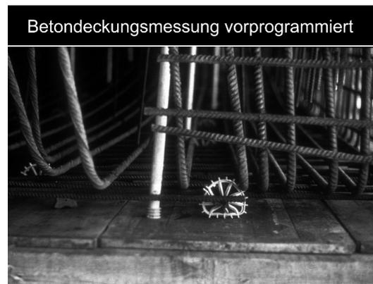
Bild 2. Eine vorgegebene Betondeckung ist nur dann als Korrosionsschutz ausreichend, wenn sie auf der Baustelle eingehalten wird. Kunststoff-Abstandhalter sollten verboten sein
