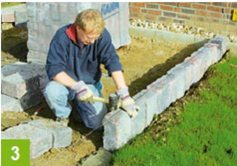
**Die Richtschnur dient als Orientierungshilfe beim Setzen der Palisaden**
