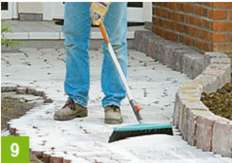
**Zum Schluss trockenen Sand oder feinen Splitt in die Fugen einkehren**
