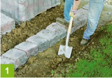
**Die Palisaden für die Beeteinfassung werden in Magerbeton verlegt**
