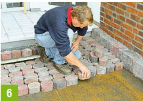
**Die Tragschicht darf nach dem Abziehen nicht mehr betreten werden**
