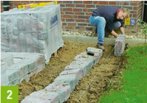
**Bevor das Betongemisch eingebracht wird, den Untergrund verdichten**
