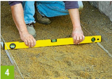
**... einlassen. Mit einer Wasserwaage die Lage der Metallschienen kontrollieren**
