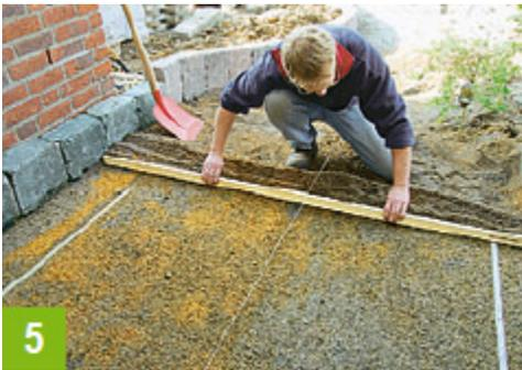
**Die Ausgleichsschicht (3 bis 5 cm dick) mit einer Abziehlatte nivellieren**
