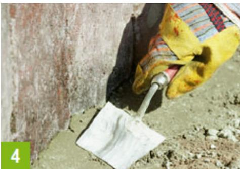
**Hinter den Palisaden wird das Fundament als sogenannte Rückenstütze ausgeführt**
