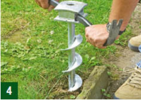
**Den Einbohranker nun mithilfe eines passenden Hebels - hier wird ein Kuhfuß benutzt - in die Erde eindrehen**
