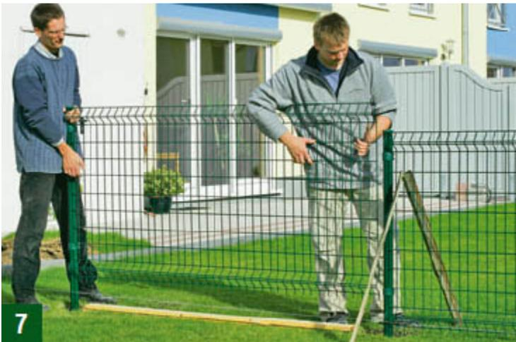
**Weiteren Beton in die beiden Erdlöcher einfüllen. Dann der Richtschnur folgend das nächste Element am Pfosten befestigen**
