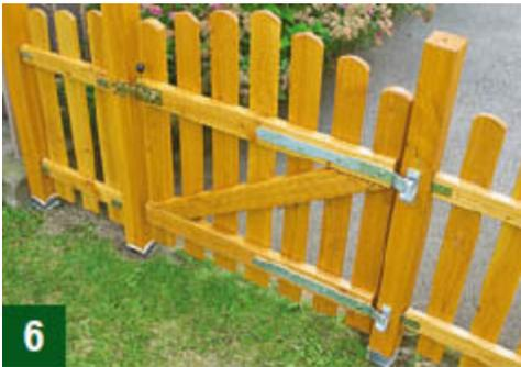
**Das fertig montierte Tor von der Rückseite. Gut zu erkennen: der stabile, Z-förmige Rahmen und die Beschläge**
