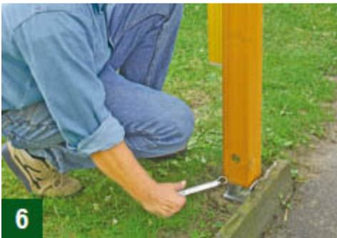
**Die allseitig glatt gehobelten Pfosten sind unten bereits mit einer senkrechten Bohrung für die Schrauben ...**
