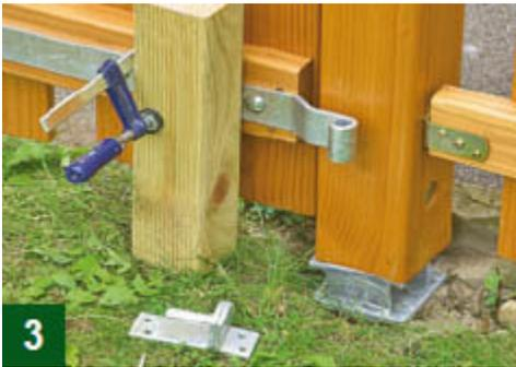
**Um das Tor in der Waage zu halten, wird es zunächst provisorisch mit einem kräftigen Kantholz abgestützt**
