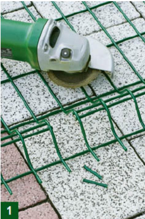
Mit dem Winkelschleifer durchtrennt man das Gitter an den Sicken, an denen es gebogen werden soll
