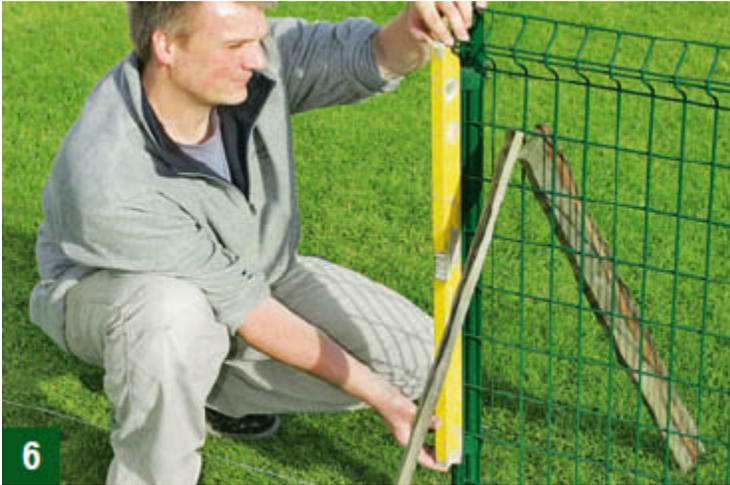
**Die Pfosten provisorisch stabilisieren und mithilfe der Wasserwaage senkrecht in beiden Dimensionen ausrichten**
