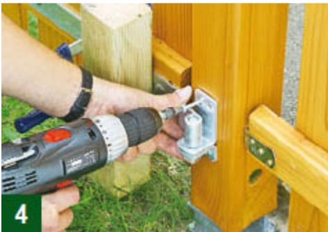
**Das Befestigen der Scharniere am Pfosten: Position markieren, vorbohren und dann verschrauben**
