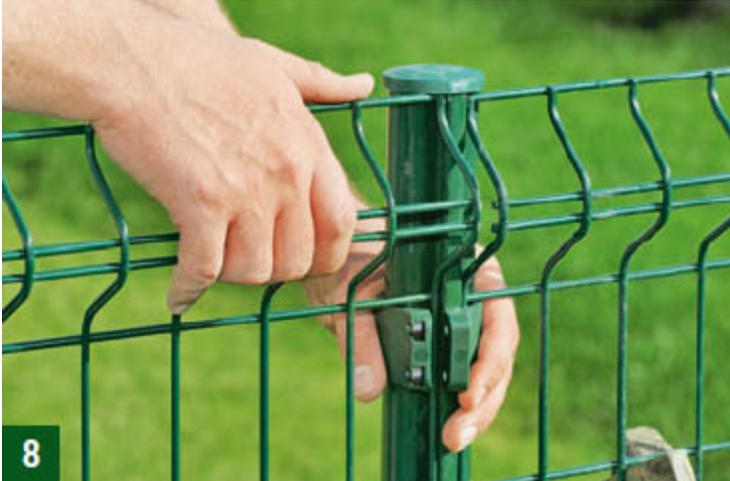
**Einfacher geht es wirklich nicht: Gittermatte für Gittermatte wird mit den praktischen Montageclips an den Pfosten fixiert**
