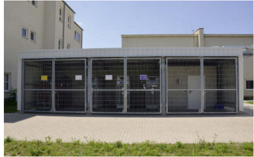
Das neuerrichtete moderne Lagergebäude für Druckgasflaschen als Stahlkonstruktion.
