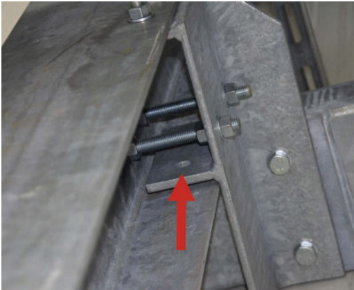
Detail der mittels Schraubenverbindungen erfolgten Anbindung des Hohlprofils mit zwei nicht genutzten Bohrungen für eine ursprünglich vorgesehene Schraubenverbindung (Pfeil).
