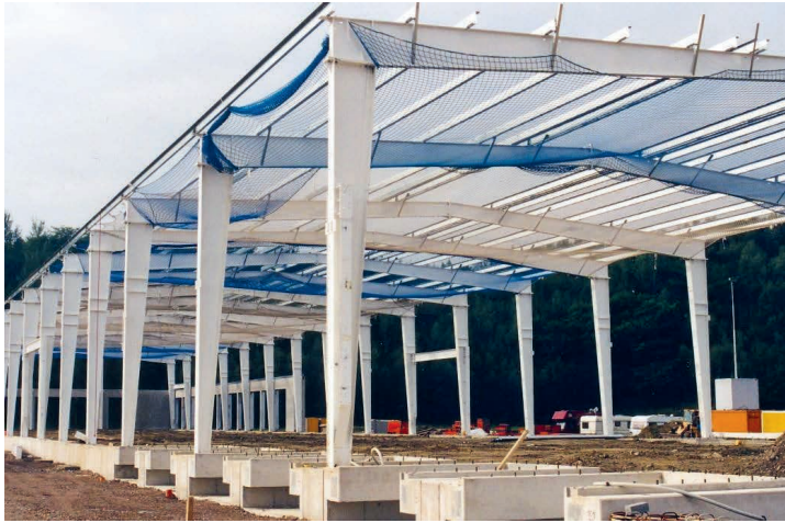
Bild 1.6 Geschweißte Zweigelenrahmen einer Lagerhalle
