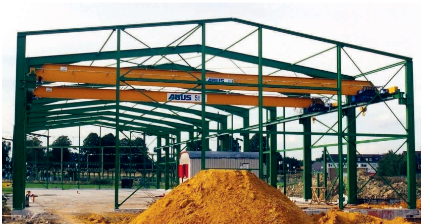
Bild 1.2 Giebelwandkonstruktion
