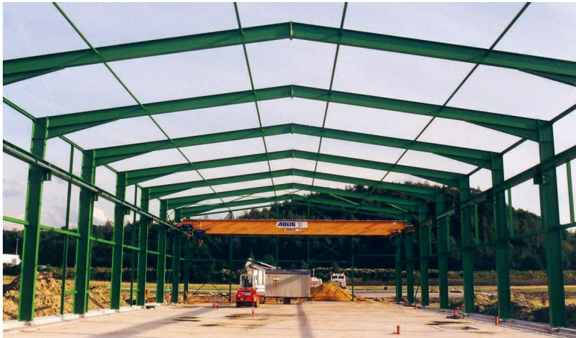
Bild 1.1 Zweigelenkrahmen einer Fertigungshalle aus Walzprofilen
