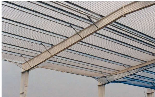
Bild 1.7 Dachpfetten, Schrägstreben und Rahmenriegel
