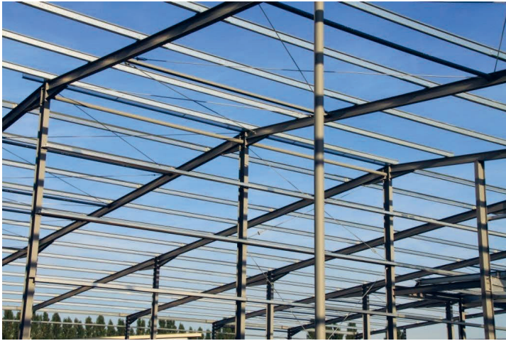
Bild 1.9 Rahmenkonstruktion und Dachpfetten
