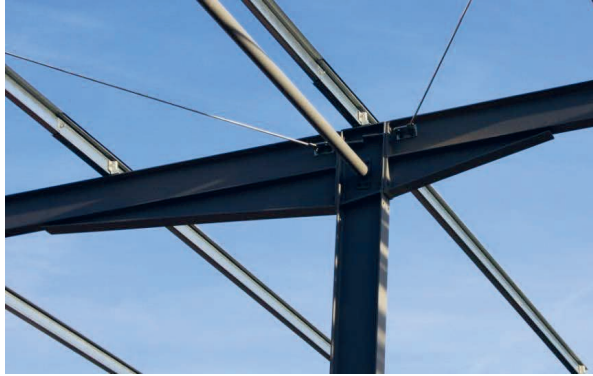
Bild 1.12 Mittelstütze mit Rahmenecken
