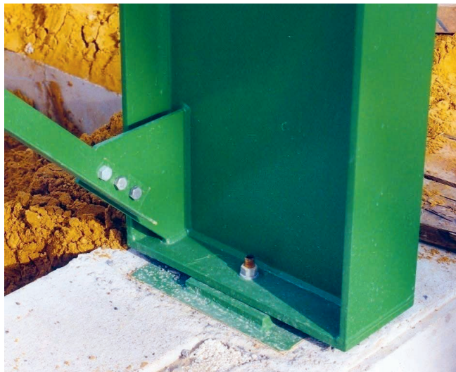
Bild 1.5 Gelenkiger Stützenfuß
