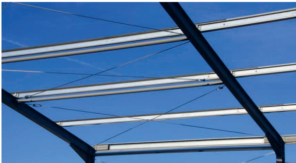
Bild 1.10 Dachverband und Pfetten
