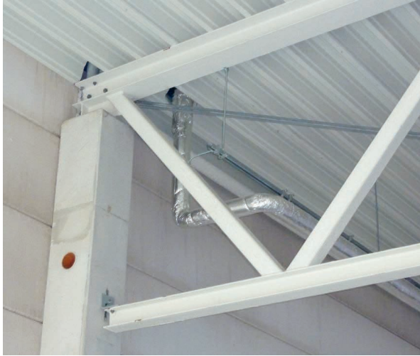
Bild 1.15 Auflagerdetail eines Fachwerkbinders
