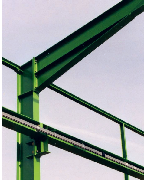
Bild 1.4 Rahmenecke mit Voute und Kranbahnträger
