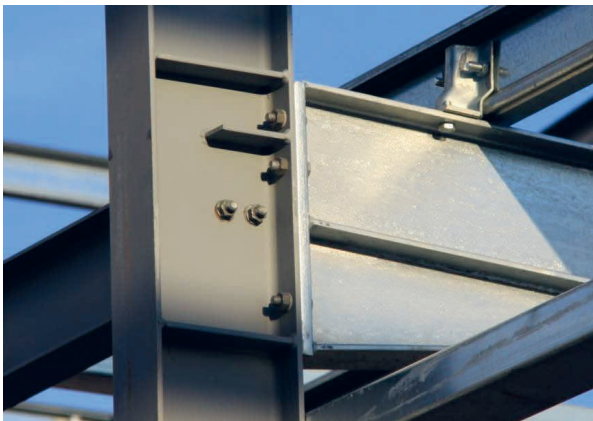
Bild 1.11 Geschraubte Rahmenecke
