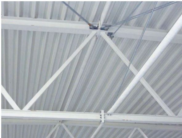
Bild 1.16 Detail Fachwerkbinder mit Stahltrapezblechen
