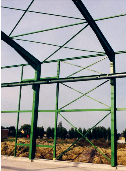
Bild 1.3 Wand- und Dachverband
