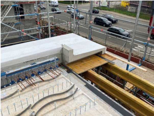
Abbildung 11: Beton-Krempe im Rohbauzustand, zusätzlich zu sehen sind die Iso-Körbe, welche die Verbindung zwischen HBV-Decke und Betonkrempe gewährleisten © P.W.S.
