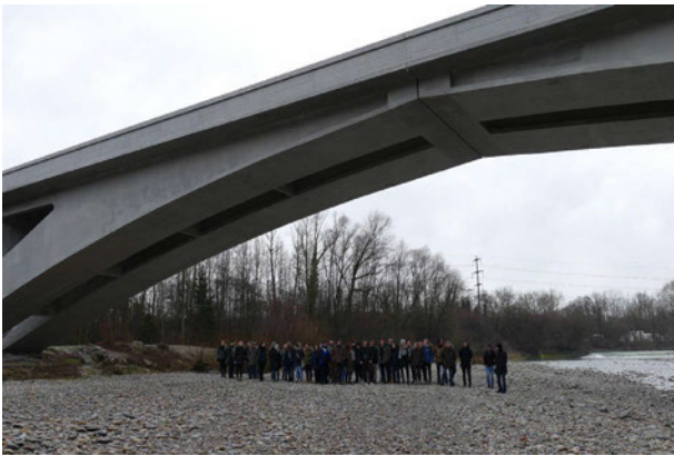
Abb. 4: Brücke nach der Stützlinie (Maillart)
