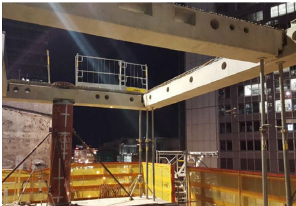
Abb. 18: Auskragender Fertigteilträger mit (unsichtbarem) Stahleinbauteil
