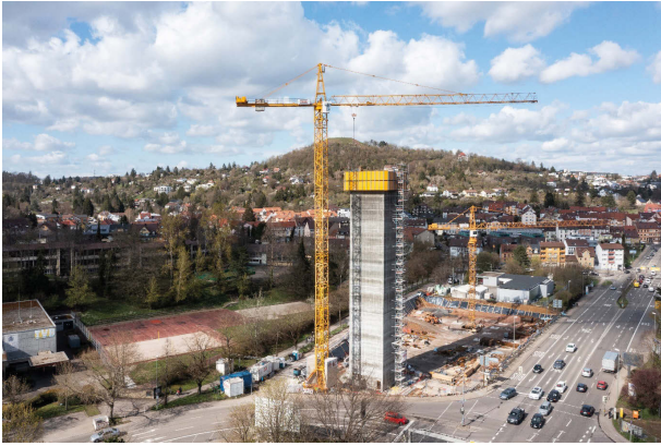
Abbildung 5: Der Treppenhaukern wuchs mittels Gleitschalverfahren in etwa 4 m pro Tag in die Höhe © Christoph von Zepelin
