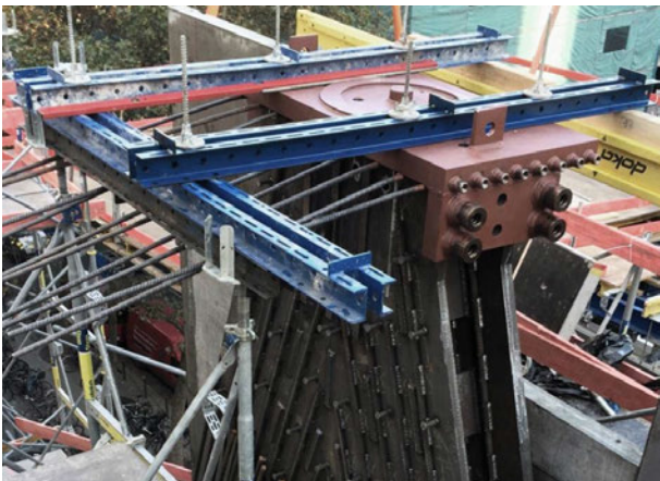
Abb. 14: Lasteinleitungsstruktur „A-Bock“
