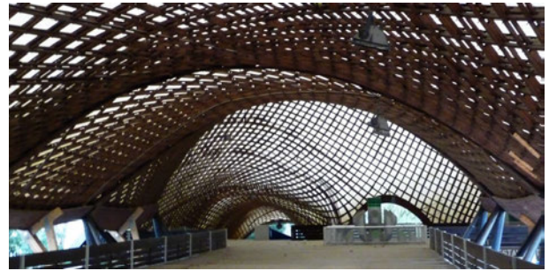
Abb. 7: Formfindung durch Schwerkraft bei der Multi-halle Mannheim
