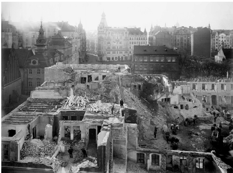
Abb. 2: Abriss der alten Prager Judenstadt (Februar 1910). Links sind die Altneu-Synagoge und das jüdische Rathaus zu sehen, rechts hinten der berühmte alte jüdische Friedhof.
