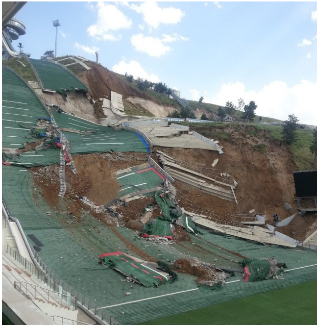
Abbildung 1.2: mangelnde geotechnische Bearbeitung führen zu Hangrutschungen
