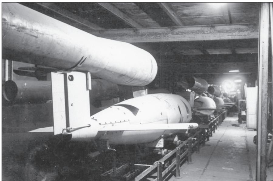
*Die Masse der Fi 103-Produktion erfolgte in den Stollen der Mittelwerk GmbH bei Nordhausen. (Zucker)*
