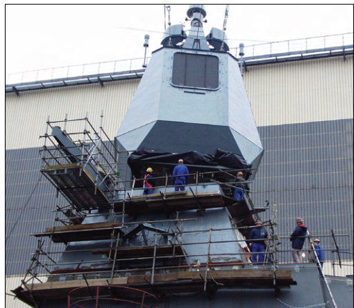
Oben links: Mit diesem 76-mm-OTO Melara-Turm nahm in den 1970er Jahre die MEKO-Entwicklung ihren Anfang. Foto: B+V
