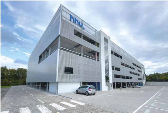
Neubau Parkhaus P1 Universität Düsseldorf
