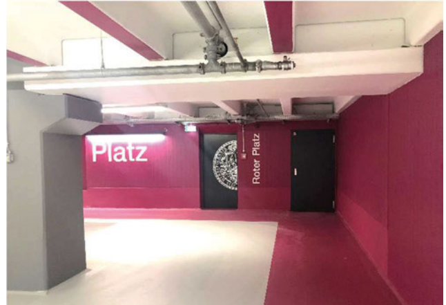
Instandsetzung Tiefgarage Unimensa Würzburg
