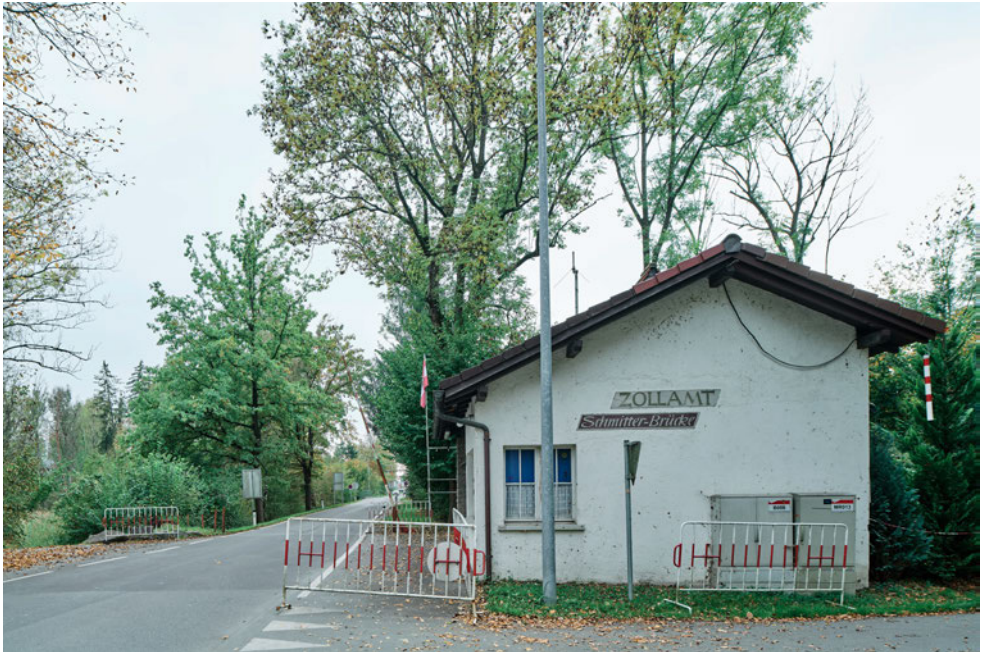
Zollamt Schmitter-Brücke, Lustenau. Foto: Miro Kuzmanovic.
