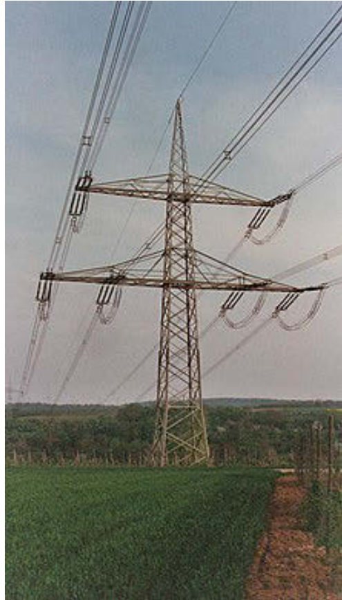
Abb. 5 Leitungsmast im Leitungszug der 380-kV-Leitung Rommerskirchen-Hoheneck [6]
