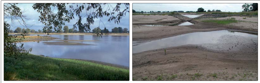
Abb. 2-4: Blick auf Bühnenfelder der unteren Mittelelbe bei Niedrigwasser mit Pionieraufwuchs und Sandbank (links) sowie Auskolkungen unter einer Kerbe im Bühnenkörper (rechts) (Fotos: Andreas Anlauf)
