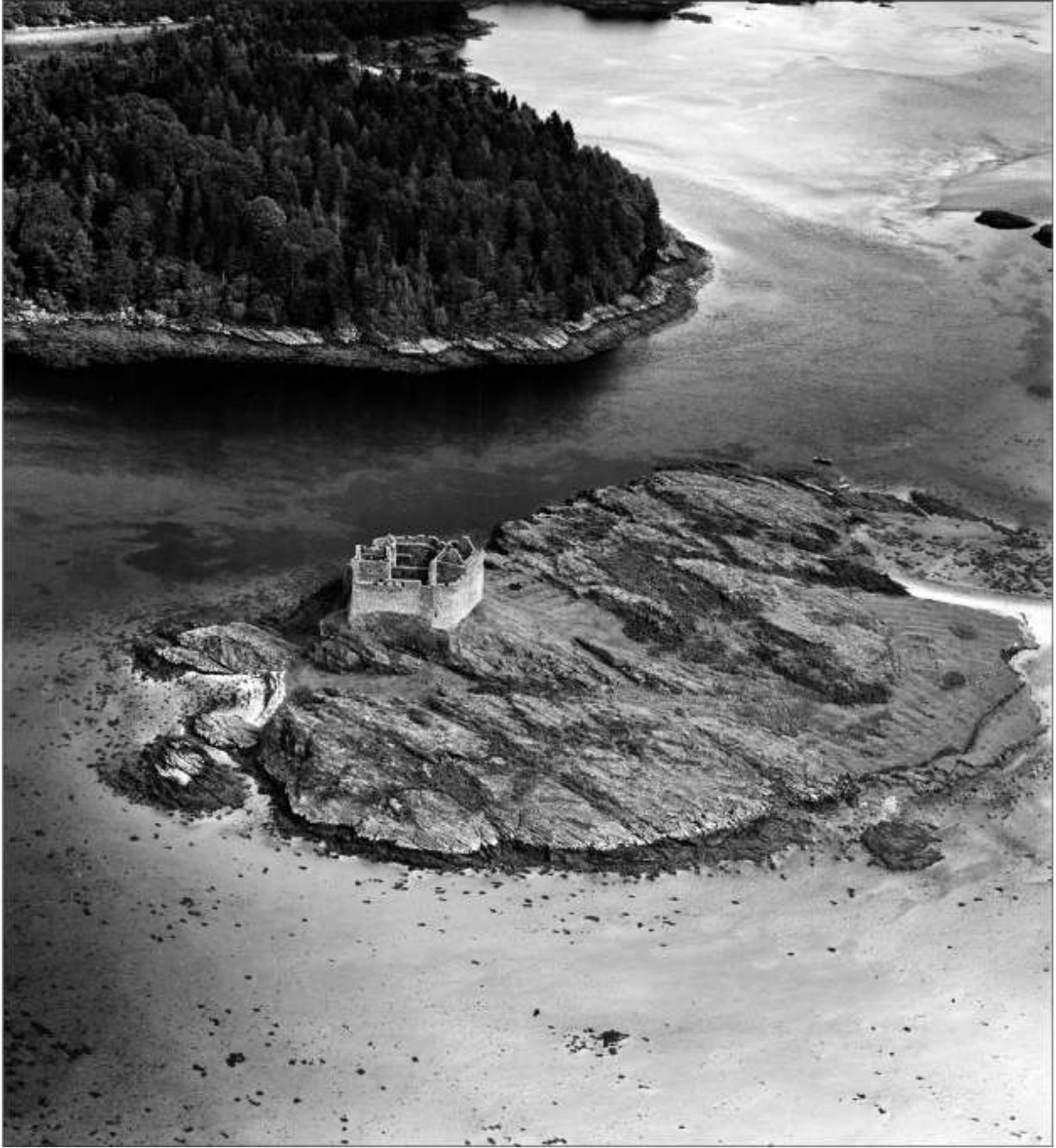
Plate 16. Castle Tioram, Eilean Tioram, Loch Moidart. aerial view.
