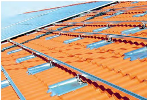
Haltekonstruktion auf Ziegeldach mit Blechersatzziegeln zur Schadensvermeidung
