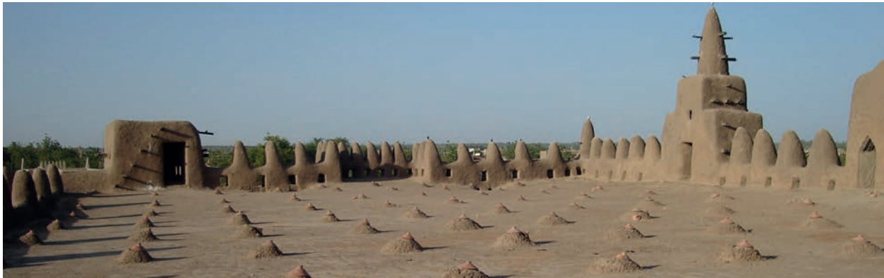
En la azotea de la Gran Mezquita de Djenné, Mali, se incorporó un diseño de convección de aire caliente que se asemeja al que utilizan las termitas. Perforaciones que atraviesan la cubierta se tapan o destapan manualmente dependiendo la hora del día para mantener estable la temperatura al interior.
