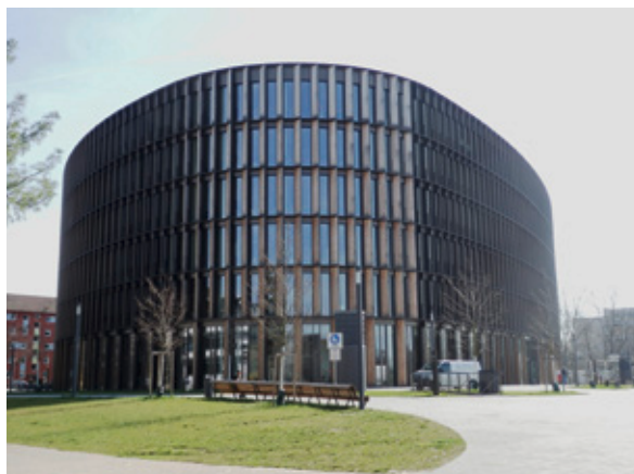
Abb. 3: Das Rathaus im Stühlinger in Freiburg i. Br. ist ein Plusenergiehaus und verfügt über höchste Umwelt- und Energiestandards.
