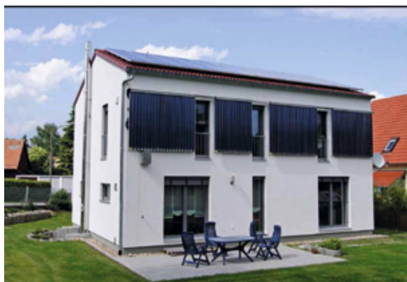
Abb. 4: Weitgehend energieautarker Einfamilienhaus-Neubau in Holzrahmenbaukonstruktion mit Anlagen zur Warmwasser- und Stromerzeugung aus Sonnenenergie
