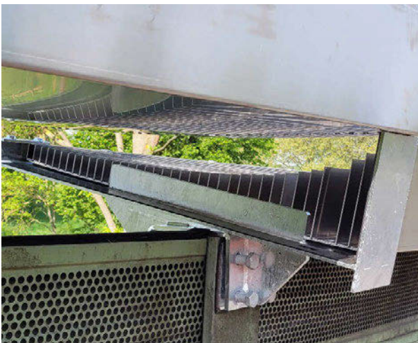
Abb. 2: Diffraktorsystem auf einer Lärmschutzwand montiert
