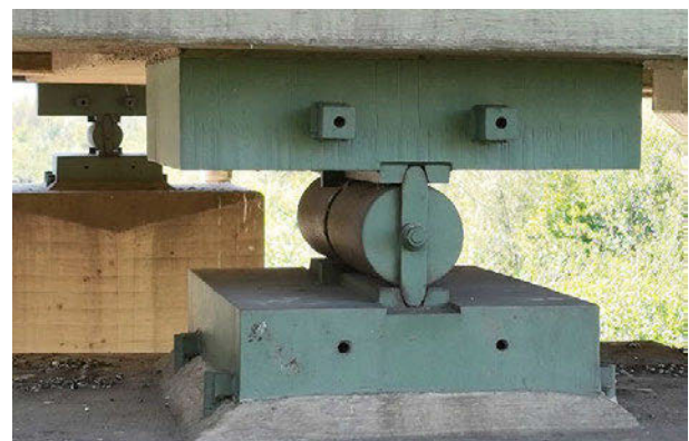
Abb. 4: Brückenlager Kontrolle durch den Betriebsdienst
