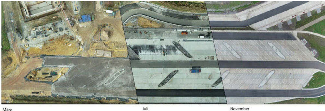
Abb. 5 Baufortschrittdokumentation mittels Luftbildaufnahmen
