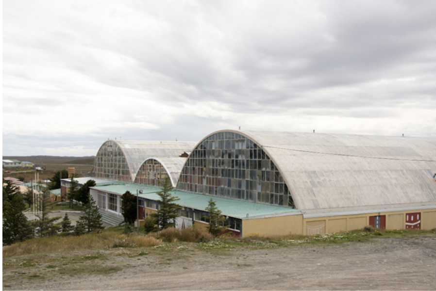
Imagen 4: Vista exterior gimnasio Cerro Sombrero, Tierra del Fuego. Fotografía: Sebastián Fortune, 2015.
