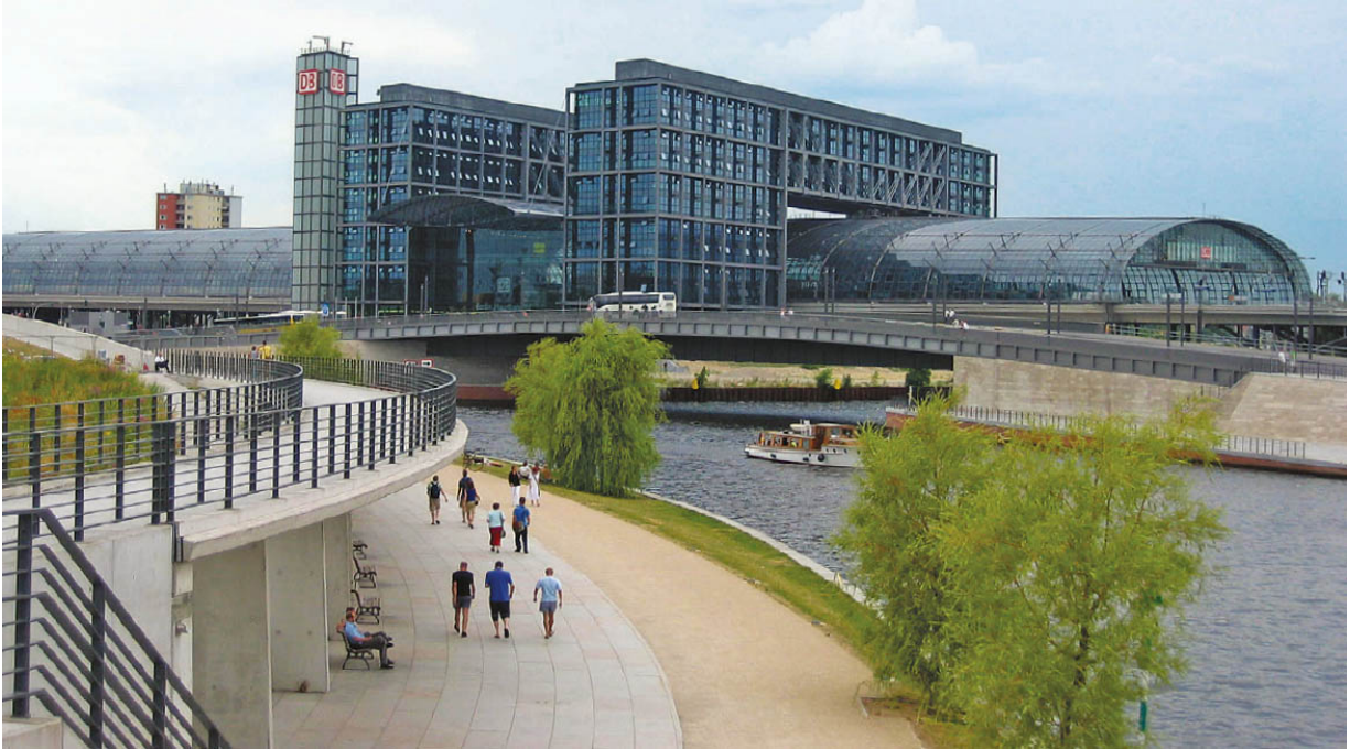
Der Berliner Hauptbahnhof wurde in den 2000er-Jahren als Turmbahnhof angelegt. Die Gleise befinden sich auf verschiedenen Ebenen. Bild: Hannelore Dörflinger
