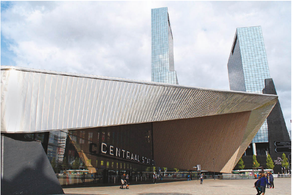
Rotterdam Centraal Station bekam 2014 ein neues Bahnhofsgebäude. Material- und Formenwelt zeigen, was im 21. Jahrhundert möglich ist. Bild: Emilie Collard
